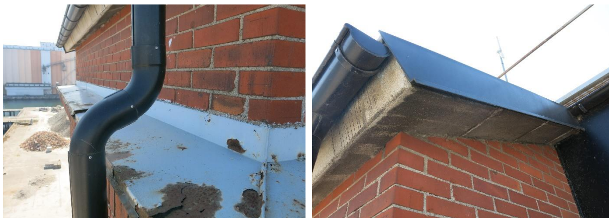
Figur 19 Den äldre plåtavtäckningen till vänster och den moderna till höger.
