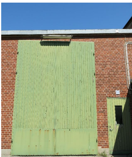
Figur 23 Till vänster den stora porten som ersatt de ursprungliga två mindre portarna. Till höger en del av avvattningen från taket på tillbyggnaderna som är ursprunglig sedan byggnadstiden.
