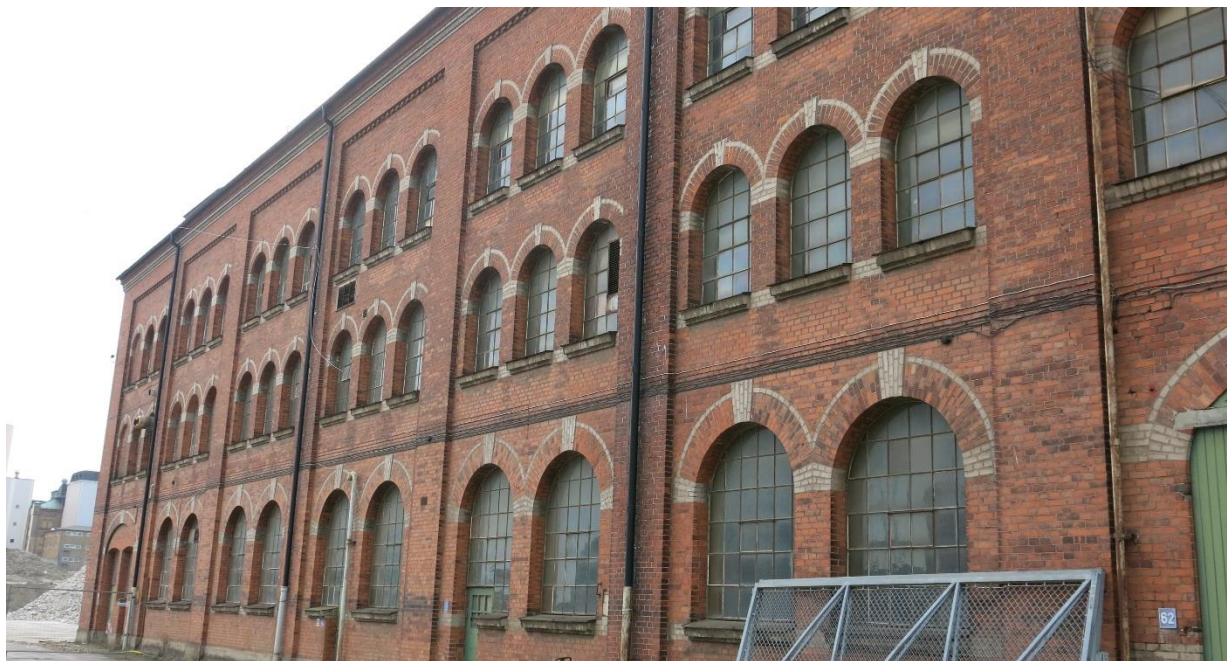
Figur 2 Magasinets östra fasad.
