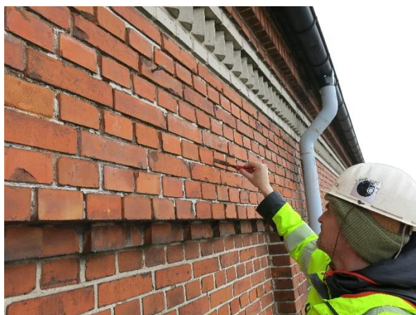
Figur 5 Flera områden har urlakade fogar, se illustrationer ovan. Kalksandstenen i de dekorativa banden i murverket är på vissa områden vittrad i ytan. Ett hörn av den västra fasaden är ommurat med nytt tegel.
