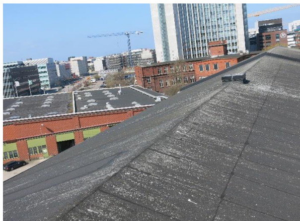
Figur 8 Befintlig tak består av en råspons klädd med takpapp.
