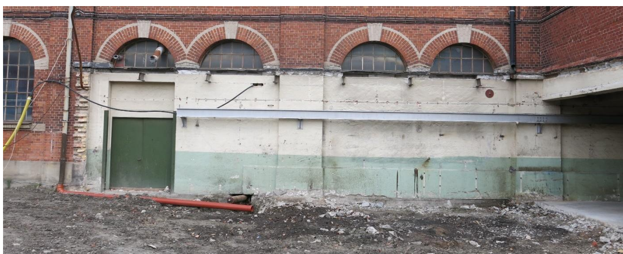
Figur 5 Bilderna ovan och nedan visar delar av fasaden som tidigare varit innerväggar i numera rivna tillbyggnader. De har blivit tunt slammade med kalkbruk och målats.
