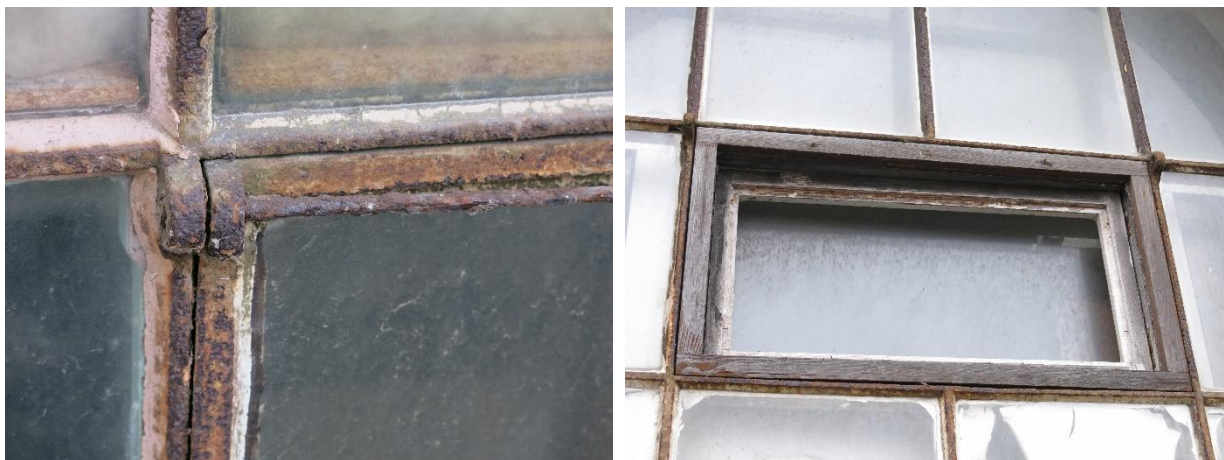
Figur 10 Vädringsfönster av gjutjärn (ursprungliga) respektive av trä.
