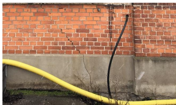
Figur 6 Till vänster sockeln på originalritningen. Till höger sprickan i sockel och murverk på den västra fasaden.
