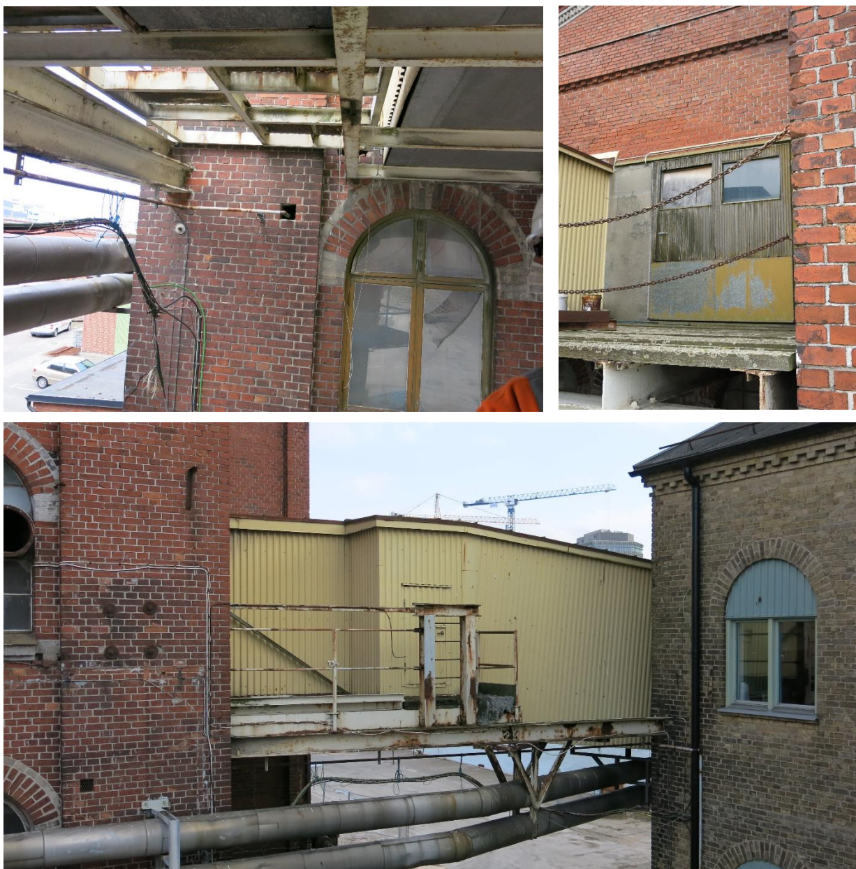
Figur 25 Gångbron består av en bärande konstruktion av stålbalkar med väggar och tak av plåt.
