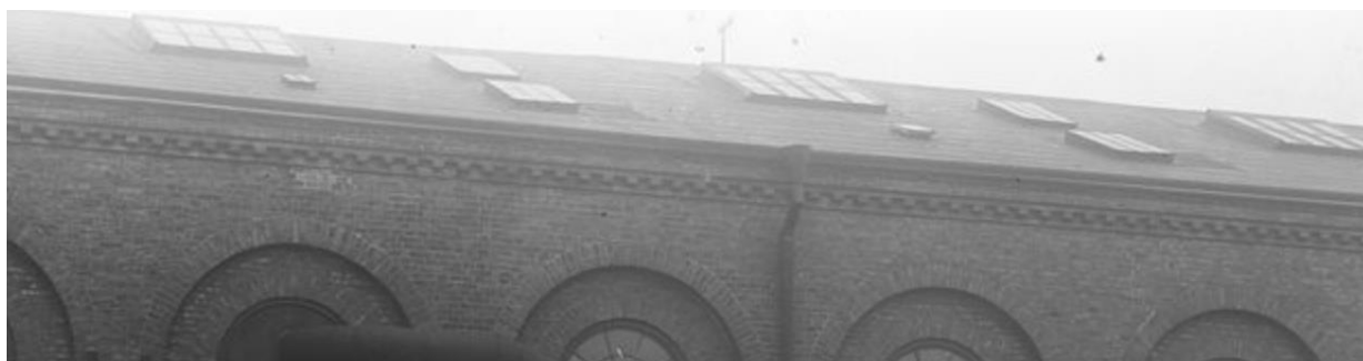
Figur 14 Exempel från den intilliggande byggnaden, vagnsverkstaden. Takfönstren (de större som är spröjsade) var något mindre än Magasinet men troligen lika i övrigt.
