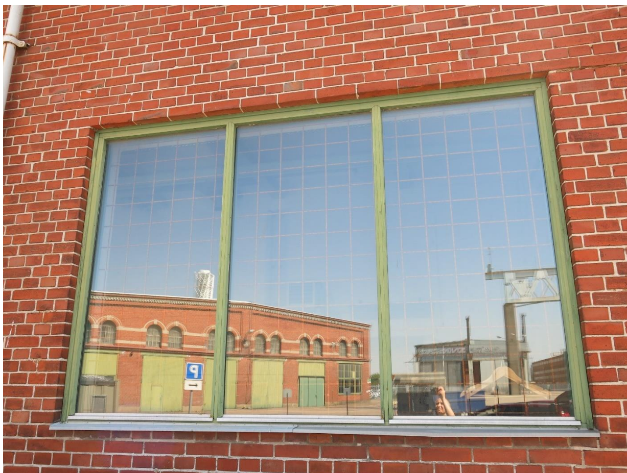
Figur 24 Ett av tre stora moderna fönster på tillbyggnaden.
